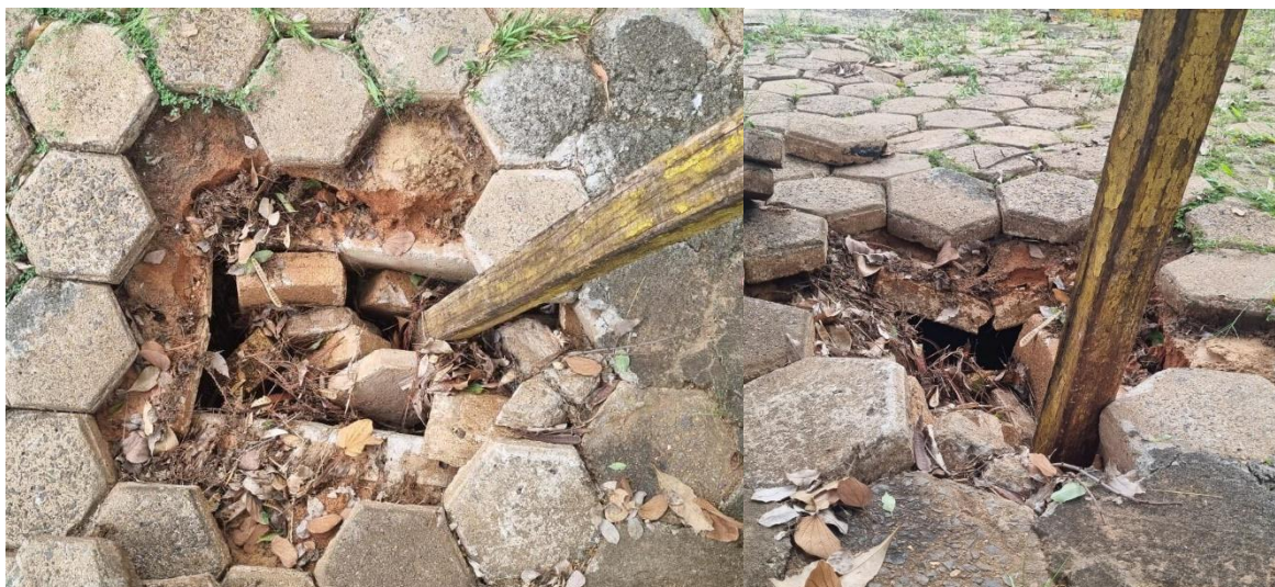
Imagem 3 e 4 - Trecho da canaleta exposta, já em ponto próximo a saída da boca de lobo.
