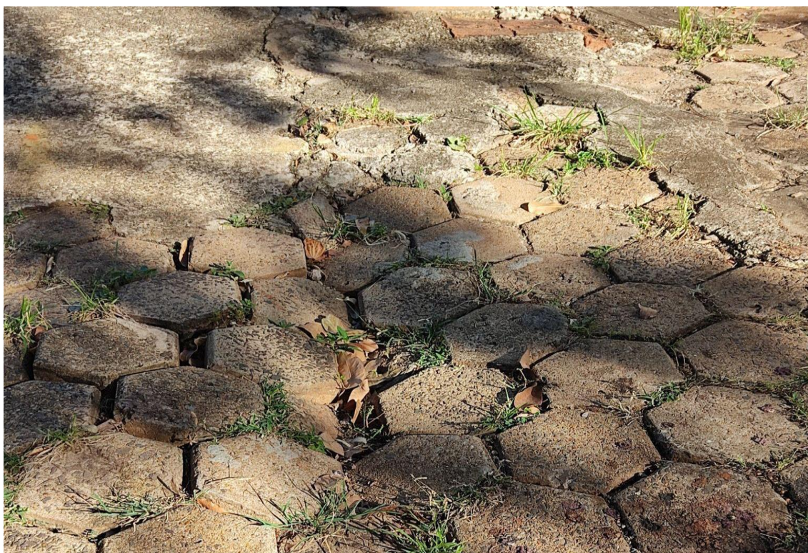
Imagem 2 - Detalhe do Afundamento
