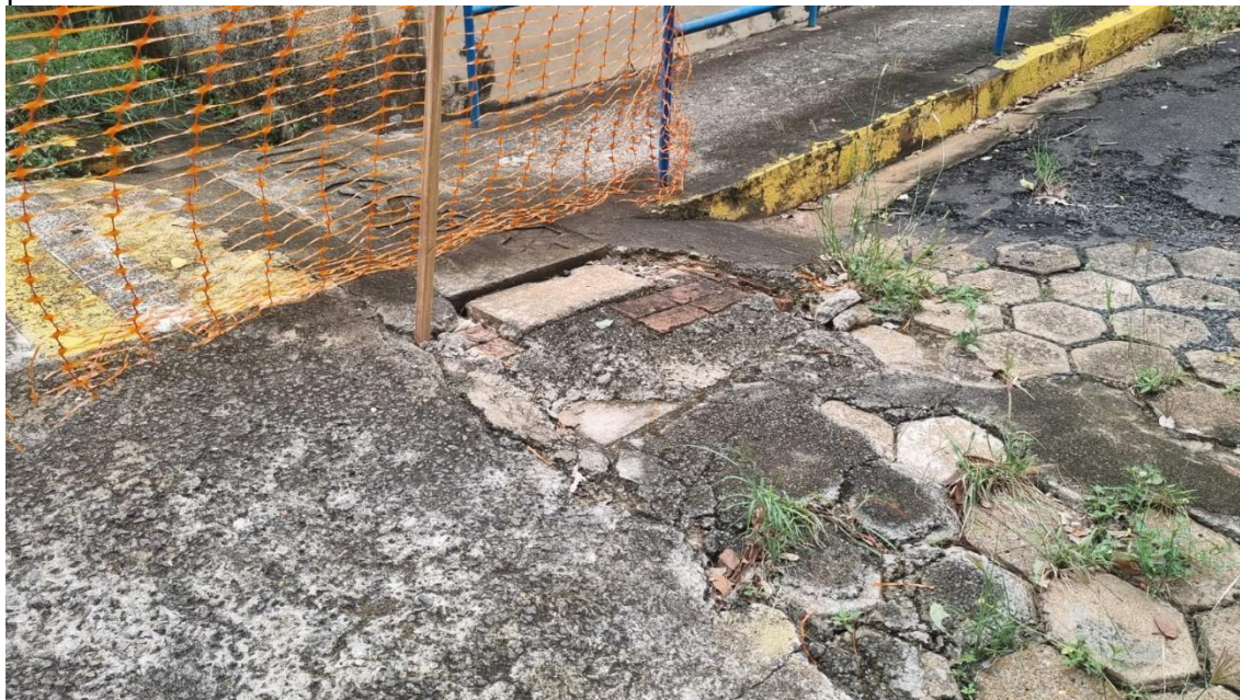
Imagem 8 – Tamba de concreto e massa soltas e desniveladas próximo a rampa de acesso
