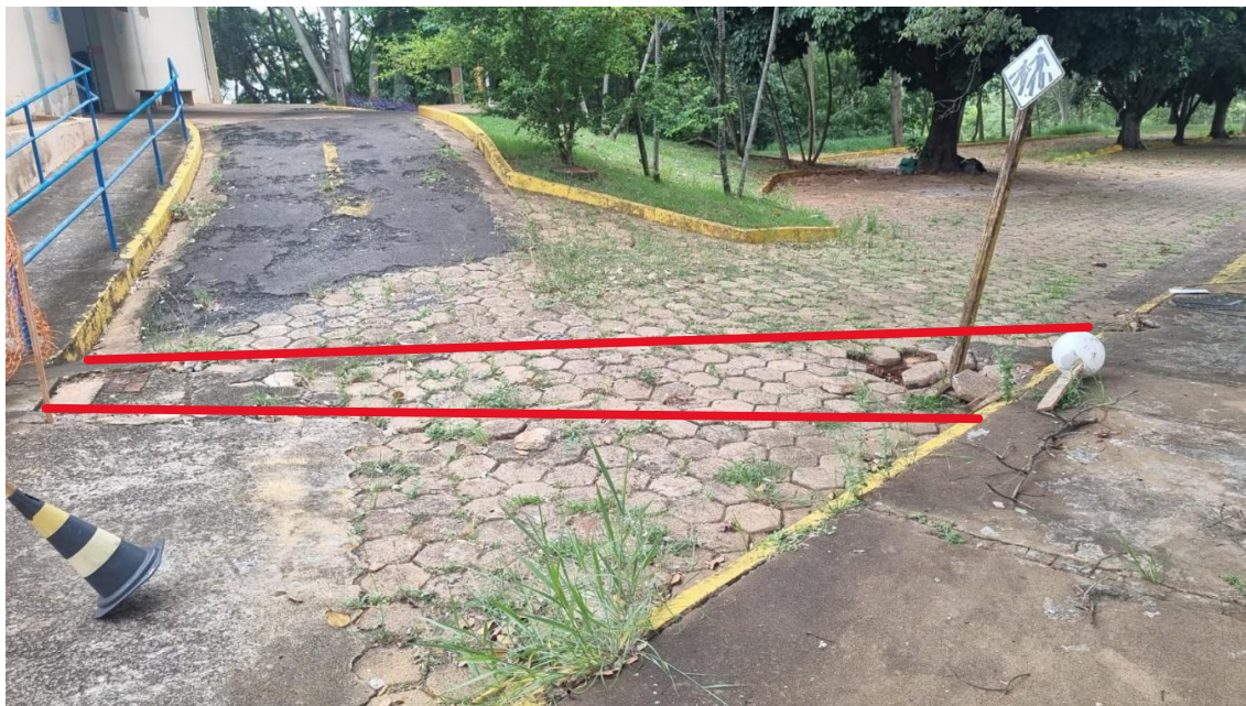
Imagem 1 – Visão geral do trecho com afundamento, com linhas indicando passagens subterrânea da canaleta
